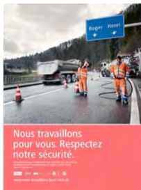
Sécurité sur les chantiers
