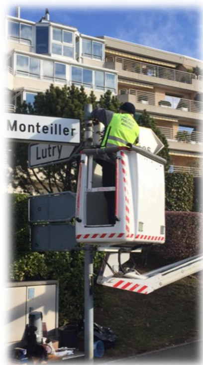
Mise en place signalisation
